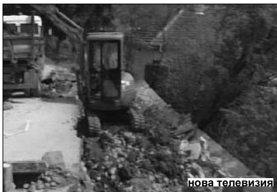
Ремонт на 18-метровата „60-метрова стена” в с. Своде
